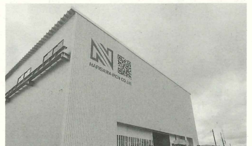
第3工場の外壁面にQRコードを塗装し、ホームページへ誘導
